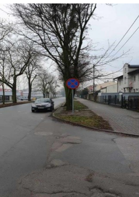
- droga powiatowa nr 2633C ul. Narutowicza w m. Aleksandrów Kujawski
